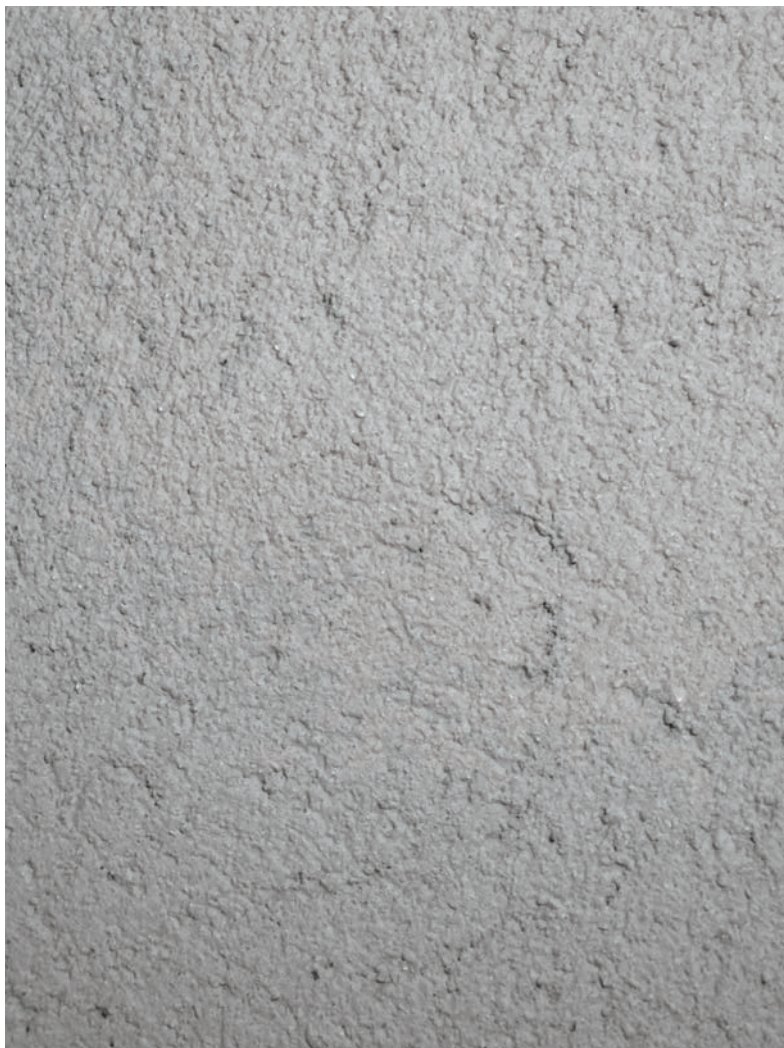
Putsstruktur 3. Oorganisk yputs, slätputsad brädriven, kornmax 2 mm
