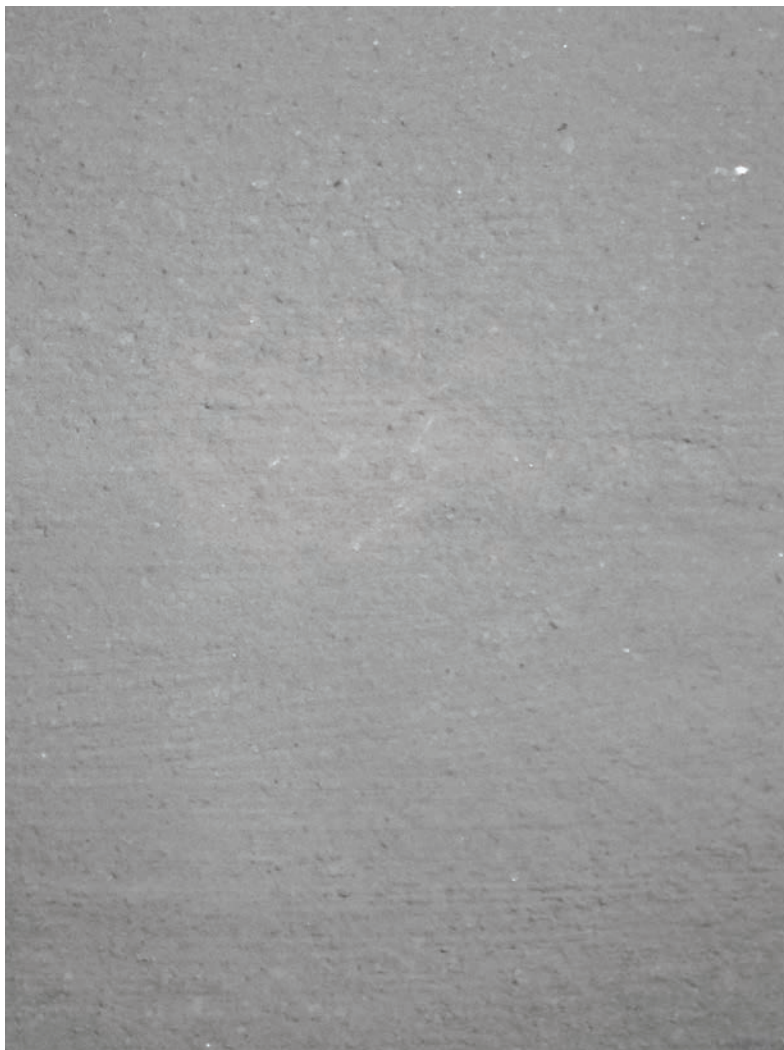
Putsstruktur 4. Oorganisk yputs, slammad kvastad yta, kornmax 2 mm
