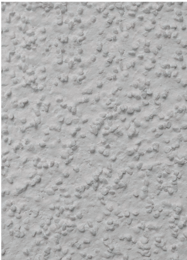
Putsstruktur 15. Organisk sprutad ytputs, kornmax 3 mm
