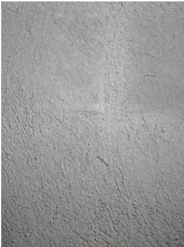
Putsstruktur 5. Oorganisk ytputs, säckskurad yta på tegel, kornmax 2 mm
