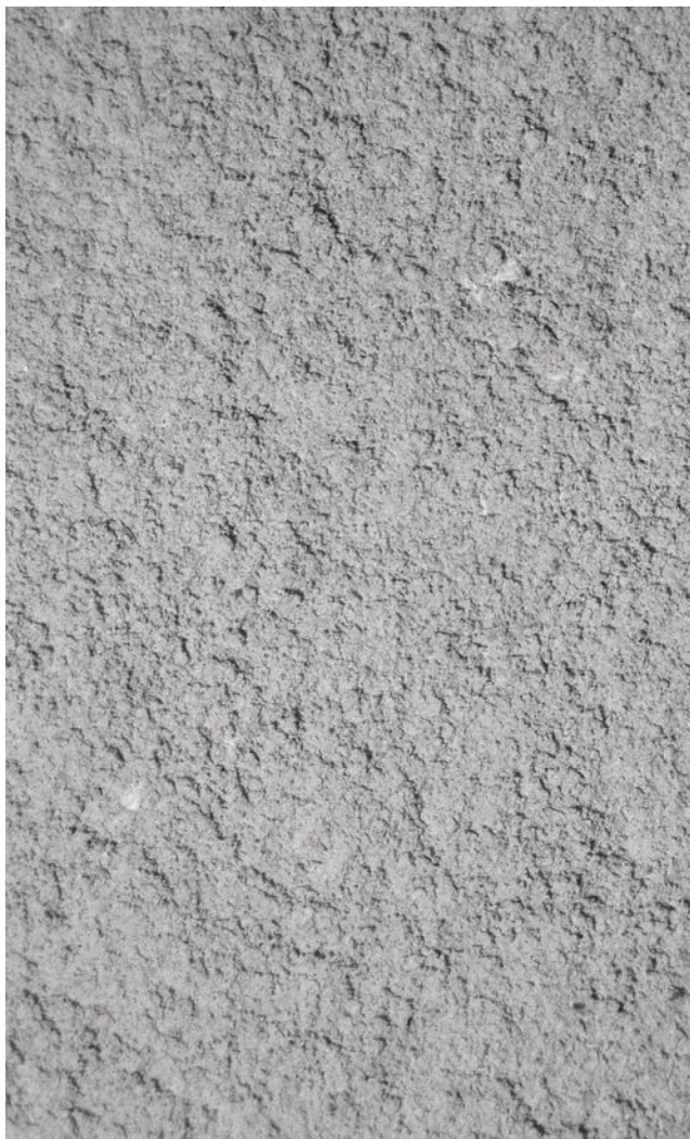
Putsstruktur 6. Oorganisk ytputs, våfflad yta, kornmax 2 mm
