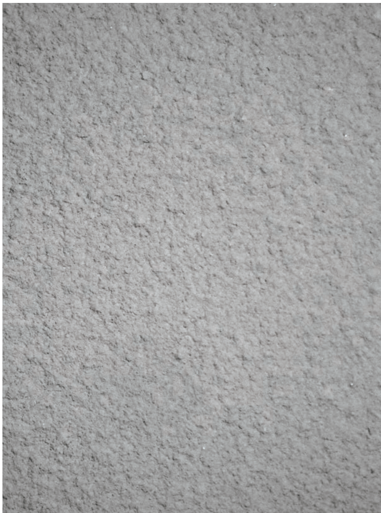
Putsstruktur 9. Oorganisk ytputs, stänkputs fin, kornmax 2 mm
