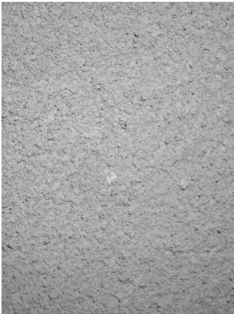
Putsstruktur 10. Oorganisk ytpuds, stänkpuds grov, kornmax 3 mm
