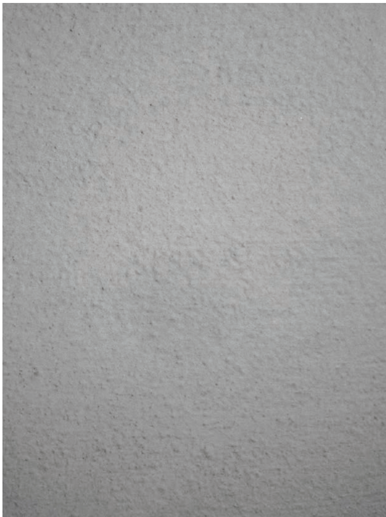
Putssstruktur 1. Oorganisk ytputs, slätputsad målad, kornmax 0,5–1 mm
